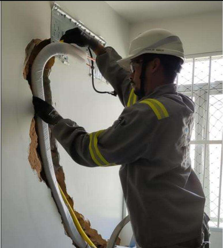
FOTO 02: INSTALAÇÃO DA NOVA INFRAESTRUTURA PARA ACOMODAÇÃO DO APARELHO AR CONDICIONADO.
