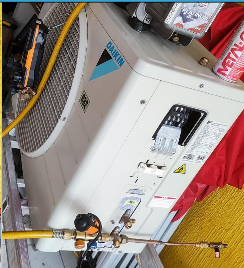
FOTO 01: EXECUTANDO PROCESSO DE EVACUAÇÃO NA UNIDADE CONDENSADORA.
