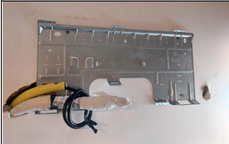
FOTO 02: DESINSTALAÇÃO DA UNIDADE EVAPORADORA E ISOLAMENTO DAS CONEXÕES COM FITAS.
