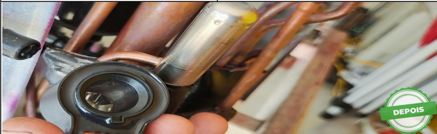
FOTO 04: VEJA COMO FICOU A VÁLVULA DE EXPANSÃO ELETRÔNICA, E BOBINA APÓS A MANUTENÇÃO EXECUTADA.
