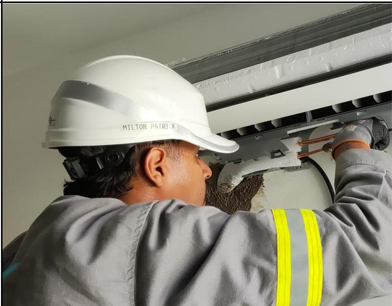
FOTO 04: REALIZANDO VERIFICAÇÃO SE HÁ VAZAMENTO NAS CONEXÕES DE 1/4 & 3/8.
