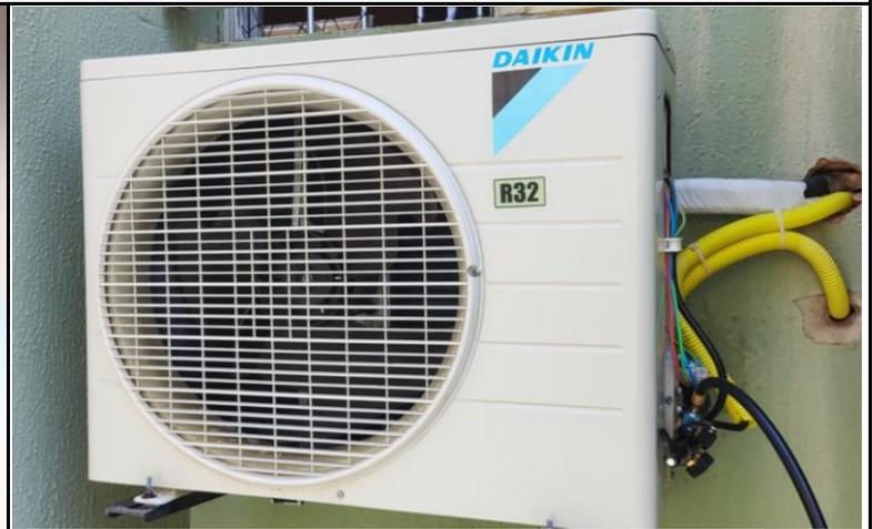
FOTO 03: UNIDADE CONDENSADORA INSTALADA NO LOCAL.
