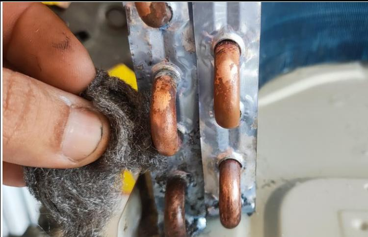
FOTO 02: EXECUTANDO LIXAMENTO NAS CURVAS DA SERPENTINA DA UNIDADE CONDENSADORA.
