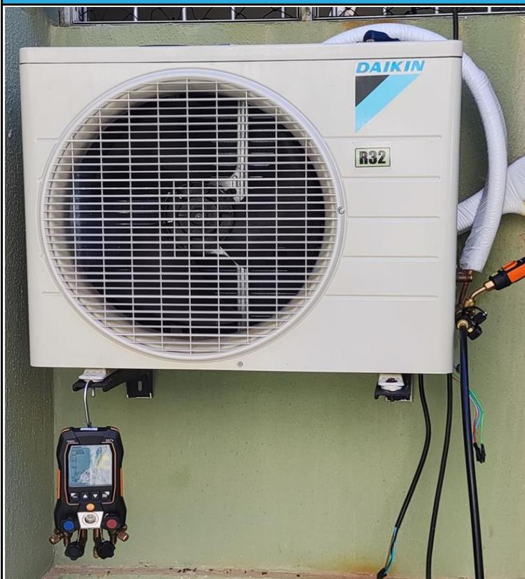
FOTO 01: EXECUTANDO PROCESSO DE EVACUAÇÃO NO SISTEMA.
