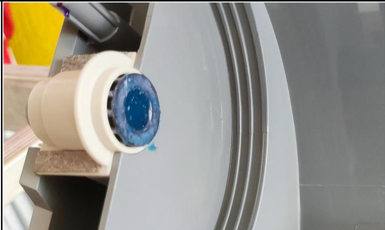
FOTO 02: APLICAÇÃO DE LUBRIFICAÇÃO NO COXIM, MANCAL DA UNIDADE EVAPORADORA.
