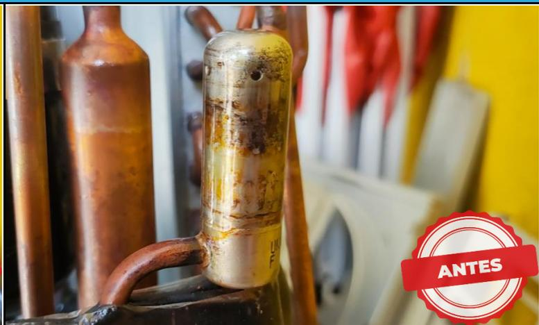
FOTO 02: VEJA COMO ESTAVA A VÁLVULA DE EXPANSÃO ELTRÔNICA, EM ESTADO DE CORROSÃO.
