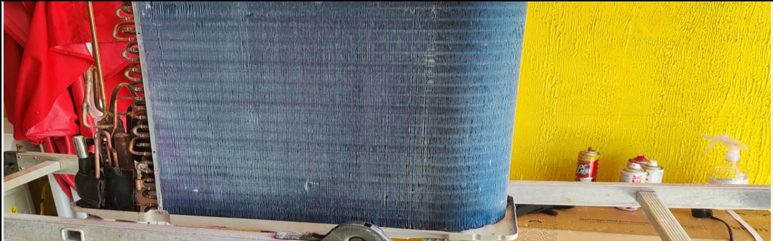
FOTO 03: SERPENTINA DO CONDENSADOR, VEJA COMO FICOU APÓS A HIGIENIZAÇÃO.
