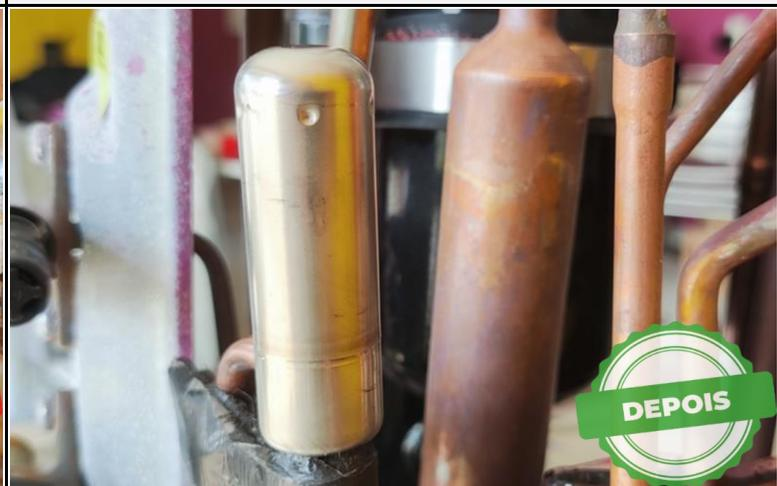
FOTO 03: VEJA COMO FICOU A VÁLVULA DE EXPANSÃO APÓS A MANUTENÇÃO.
