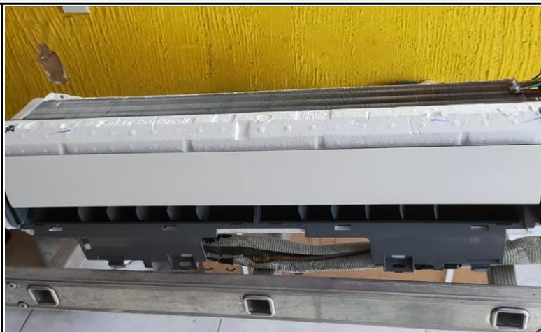
FOTO 05: UNIDADE EVAPORADORA MONTADA COMPLETA.
