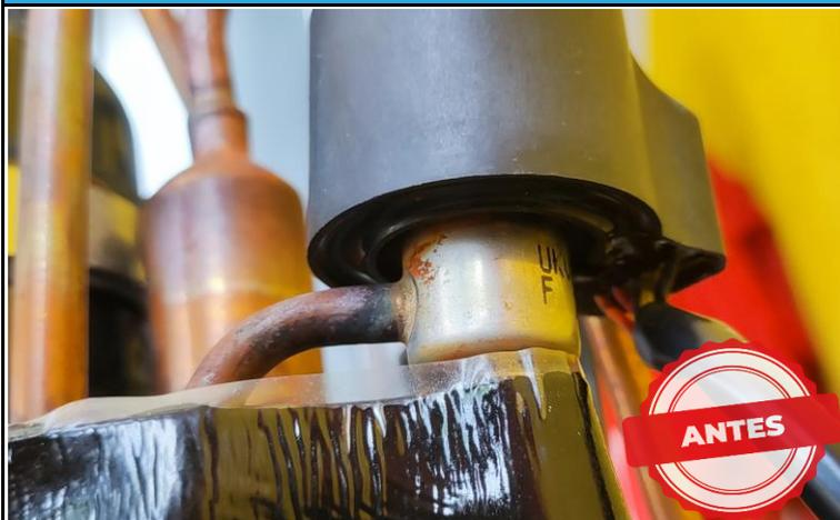
FOTO 01: VALVULA DE EXPANSÃO ELETRÔNICA COM IMPREGNAÇÃO DE CORROSÃO.
