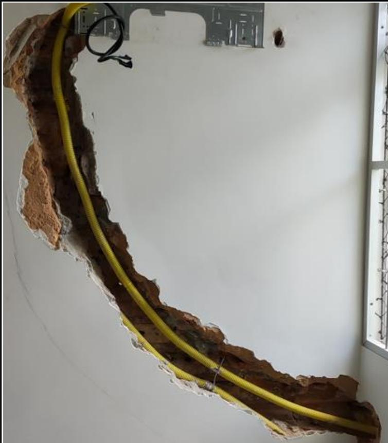
FOTO 01: REMOÇÃO DA INFRAESTRUTURA ANTIGA, PARA INSTALAÇÃO DA NOVA INFRAESTRUTURA.
